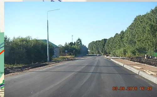
Капитальный ремонт а/д «Усть-Вага – Ядриха» км 237 – 248, 11 км, ввод в 2019 г.
